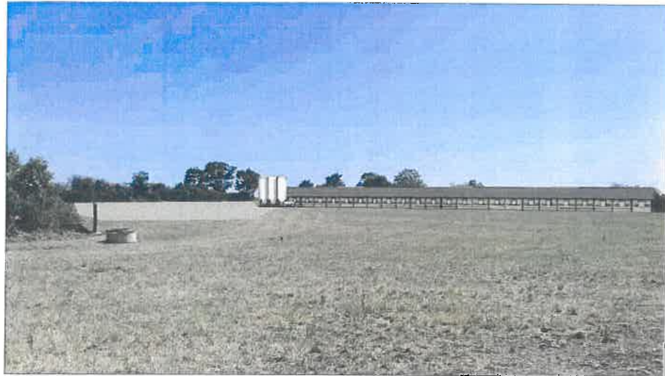
PC 6 Après travaux
